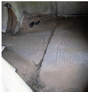
A3 “concrete box”
